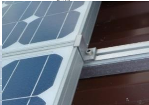
Blitzschutzanlage weder eingebunden noch Trennungsabstand eingehalten
