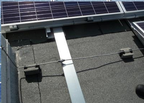
Blitzschutzanlage weder eingebunden noch Trennungsabstand eingehalten
